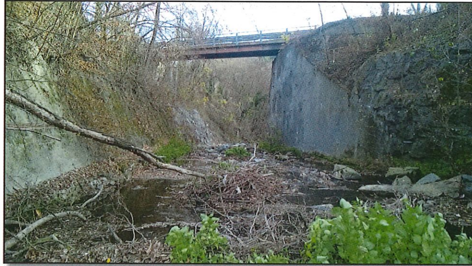
Brévenne en aval du seuil
